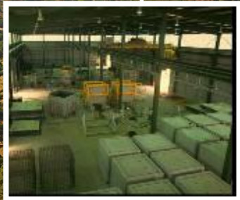
NAVE DE FABRICACIÓN DE CONTENEDORES
