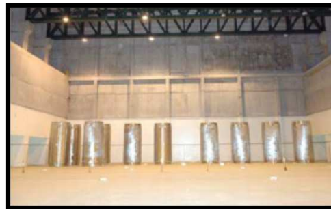
Interior del AT1 de Trillo. Contenedores metálicos
